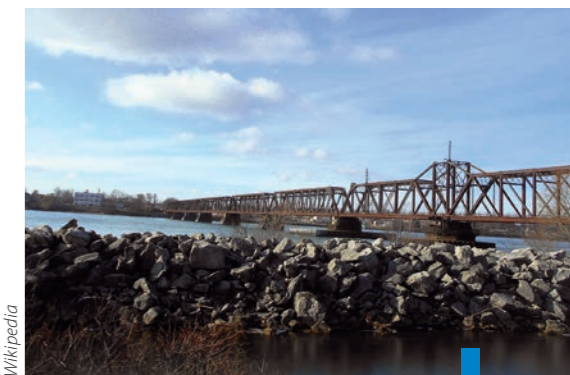
Międzynarodowy Most Kolejowy na rzece Niagara
